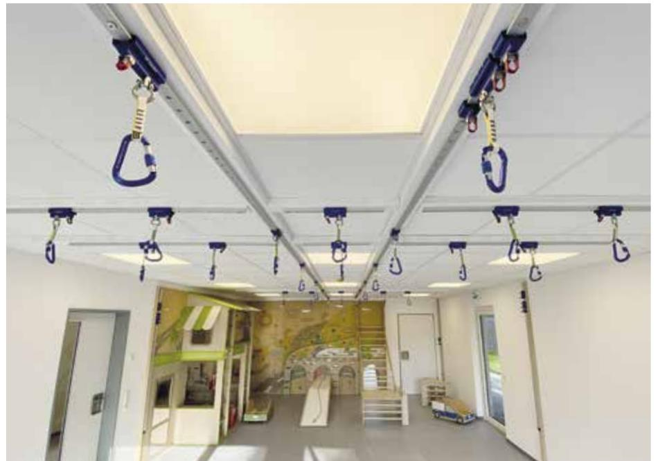
horizontales und vertikales Schienensystem
