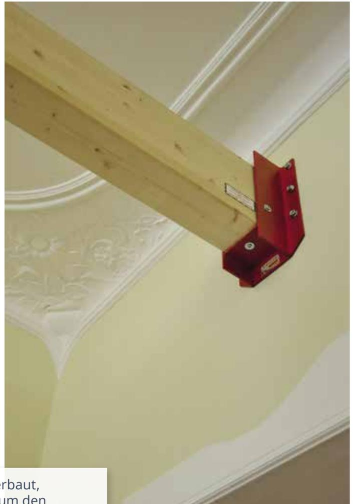
Bei dieser Montage wurde eine Balkenkonstruktion so verbaut, dass vorhandener Deckenstuck nicht beschädigt wurde, um den Denkmalschutz des Gebäudes nicht zu verletzen.
